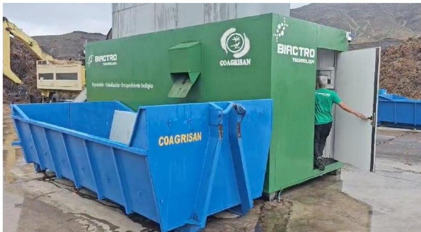
Biocatalysis module in operation. La Aldea de San Nicolás de Tolentino, Gran Canaria.
